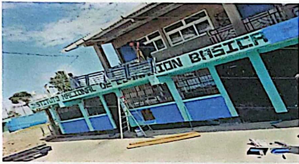
Foto 1: Vista de aulas del segundo nivel durante la instalación de las barandas.
