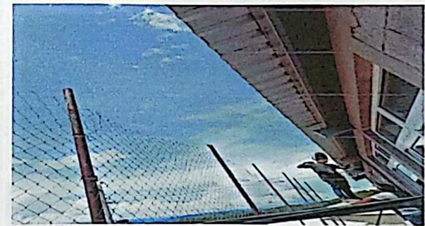
Foto 4: Vista del techo durante la instalación del canal.
