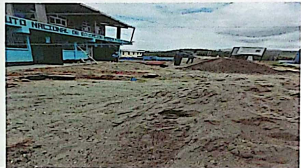
Foto 2: Vista del patio educativo durante la construcción escolar.
